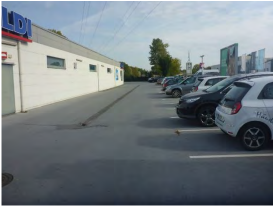
Abb. 7 Blick von Westen auf das Plangebiet.
