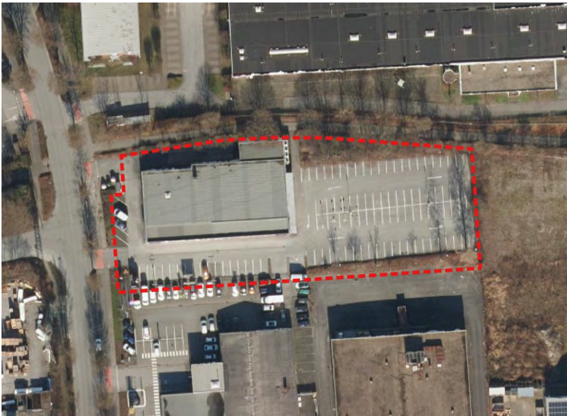
Abb. 6 Bestandssituation im Plangebiet (rote Strichlinie) auf Grundlage des Luftbildes.
