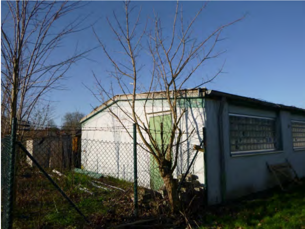
Foto 12: Das gleiche gilt für dieses Gebäude welches sich ebenfalls südlich des Hauptgebäudes befindet.
