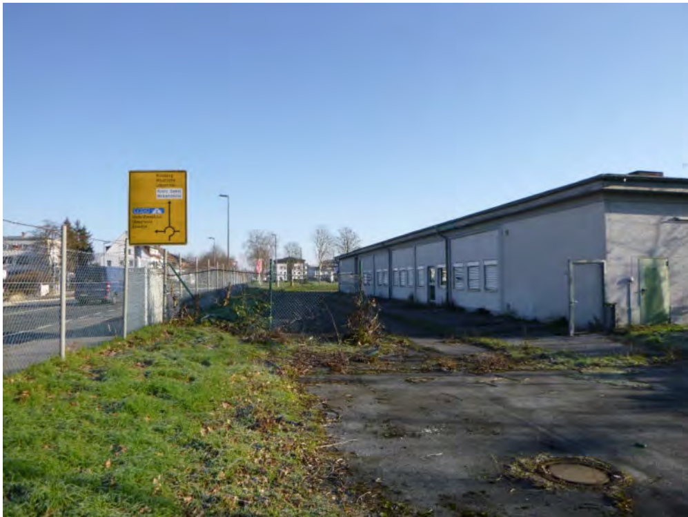
Foto 5: Der westliche Teil des B-Plangebietes, Blickrichtung Norden.
