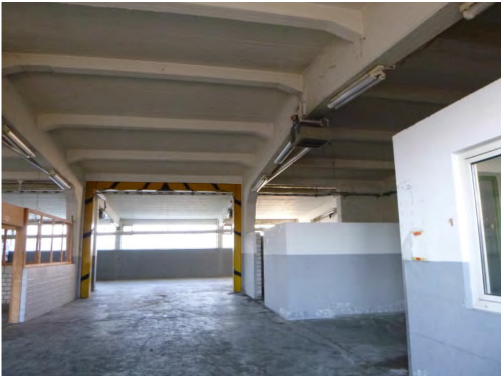
Foto 13: Den Hauptteil des Gebäudekomplexes nehmen Werkstatthallen in Anspruch. Daneben sind verschiedene Räume als Büro, Sanitärräume usw. genutzt worden.
