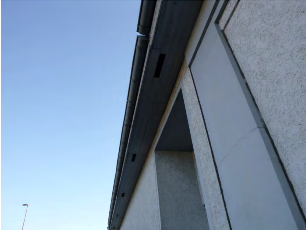
Foto 10: Die Traufkästen weisen Spalten auf, die Einflugmöglichkeiten für Gebäudebrüter (z. B. Bachstelze, Hausrotschwanz) und auch gebäudebewohnende Fledermausarten (z. B. Zwergfledermaus) bieten. Daher sollten diese Bereiche im Beisein einer artenschutzfachlichen Ökologischen Baubegleitung zurückgebaut werden.
